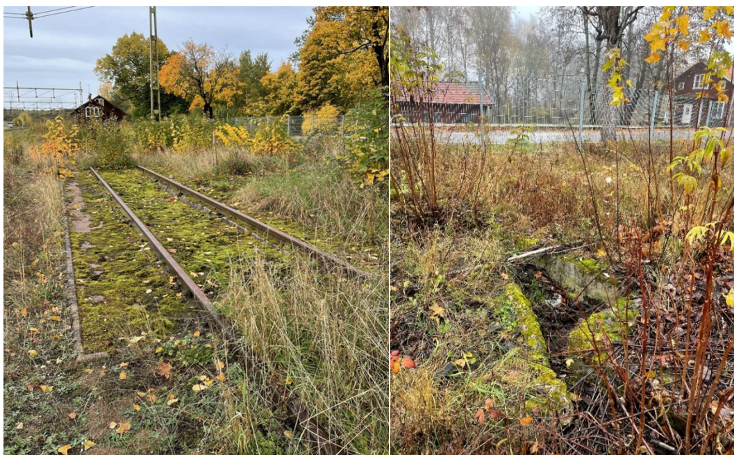
Figur 10. T.v. Betongkonstruktion (f.d. lokstall). T.h. Betongkonstruktion (f.d. transformatorstation).
