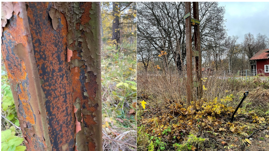
Figur 11. T.v. Kontaktledningsstolpe målad med blymönja. T.h. Provtagning av jord runt kontaktledningsstolpe 112-14a.
