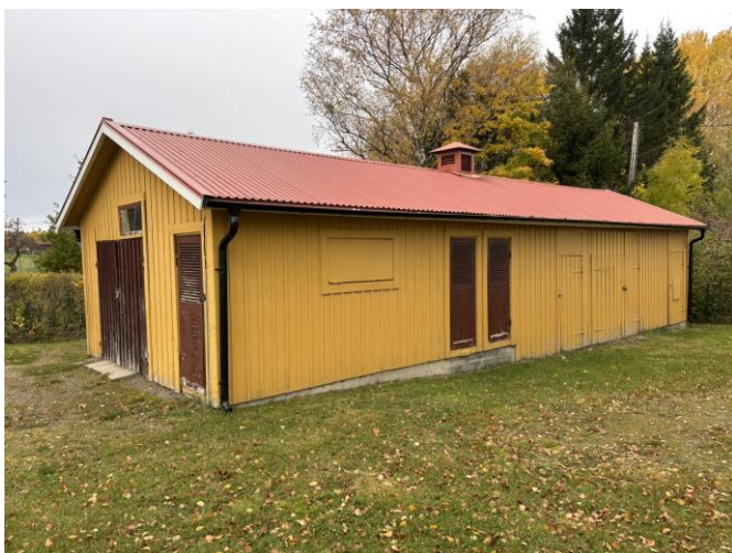
Garage/förrådsbyggnad i områdets västra del.
