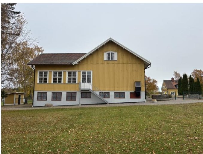
Fasad mot väster, ny utrymningstrappa samt ventilationshuv har tillkommit.
