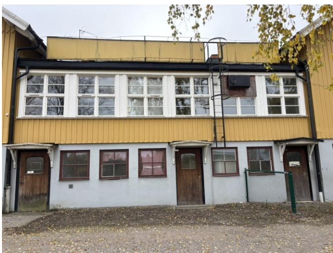
Utrymningsväg från övre våningen samt nya tekniska installationer har tillkommit, annars är skolbyggnaden relativt välbevarad från uppförandetiden.
