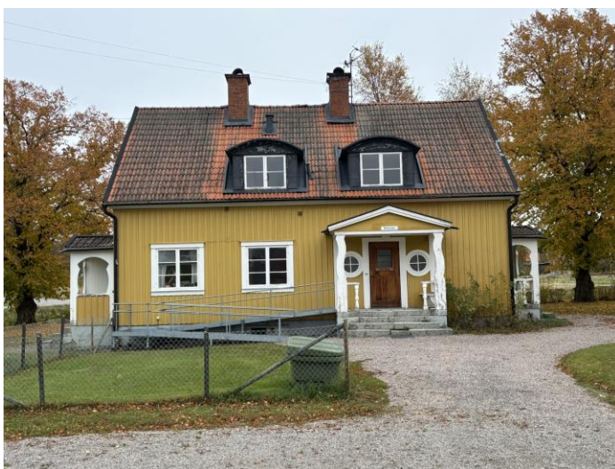
Den östra lärarbostaden är större än den västra. Ny ramp har tillkommit annars är lärarbostaden välbevarad från uppförandetiden.
