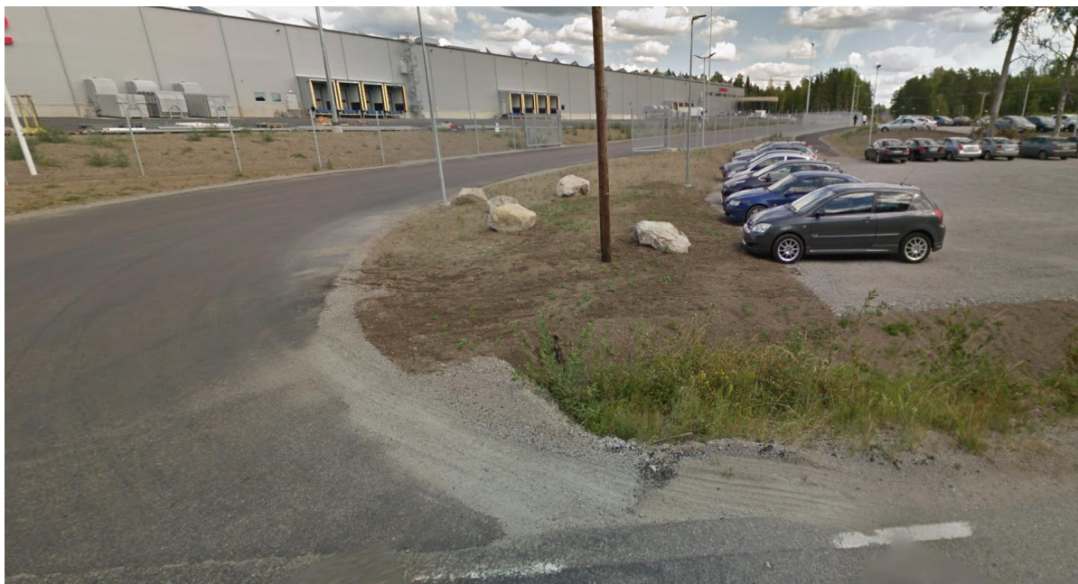
Figur 9 Vy österut från Molnebovägen in mot Apotea. Hjulspår kan anas utanför körbanekant (Bild från Google maps)
