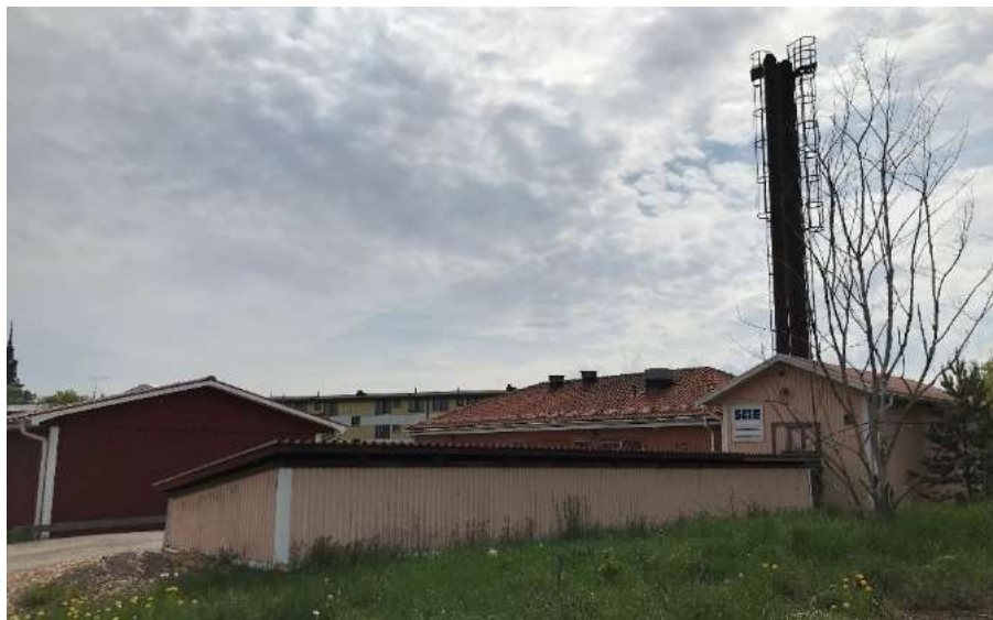
Fjärrvärmeanläggningen i den västra delen av planområdet.
