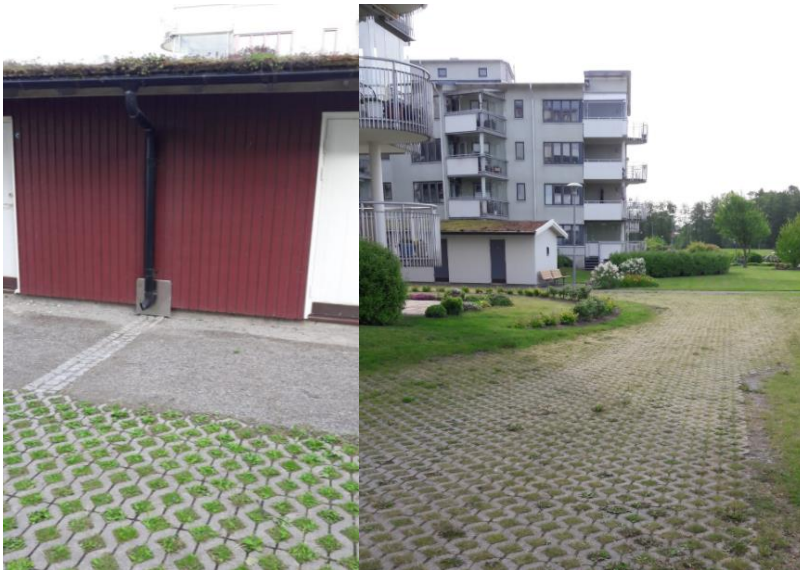
Figur 15. Genomsläpplig markbeläggning på infarter, parkeringar och gångbanor på innergård. Foton tagna från Heby kommuns bildgalleri på lokal dagvattenhantering. https://heby.se/samhalle-infrastruktur/vatten-och-avlopp/dagvatten/bildgalleri-pa-lokal-dagvattenhantering/
