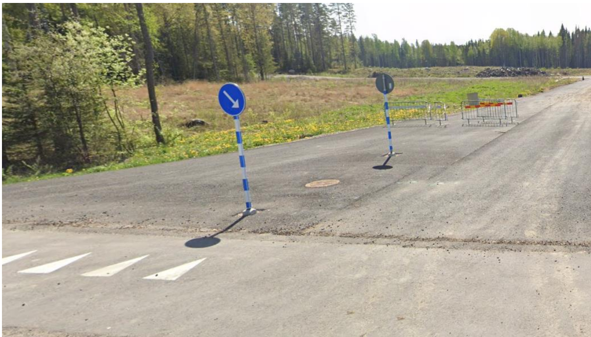
Figur 13. Befintlig utformning av anslutning från Timmergatan till väg 72 med två D2- Påbjuden körbana.
