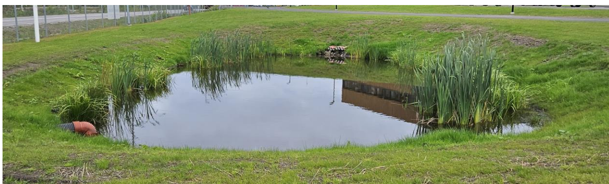
Figur 8.2. Exempel på en dagvattendamm (foto: FVB).
