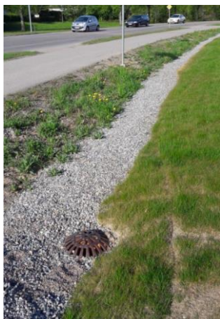
Figur 22. Exempelbild på stråk längs med gatumark. I bild ovan är stråket beklädd med gräs och kross. Foto taget från Heby kommuns bildgalleri på lokal dagvattenhantering. https://heby.se/samhalle-infrastruktur/vatten-och-avlopp/dagvatten/bildgalleri-pa-lokal-dagvattenhantering/
