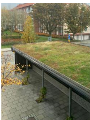
Figur 21. Exempelbild på skärmtak med växtlighet. Vid tillfällen då växtligheten och jorden är mättad samlas vatten upp i hänggräna. Foto taget av Bjerking AB.
