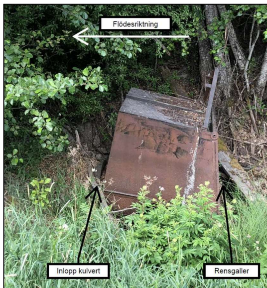
Figur 10: Inlopp till kulverten med tillhörande rengaller. Foto taget vid sidan av Rävsjöbäcken, flödesriktning från höger till vänster i bild. Foto från platsbesök 2018-06-12
