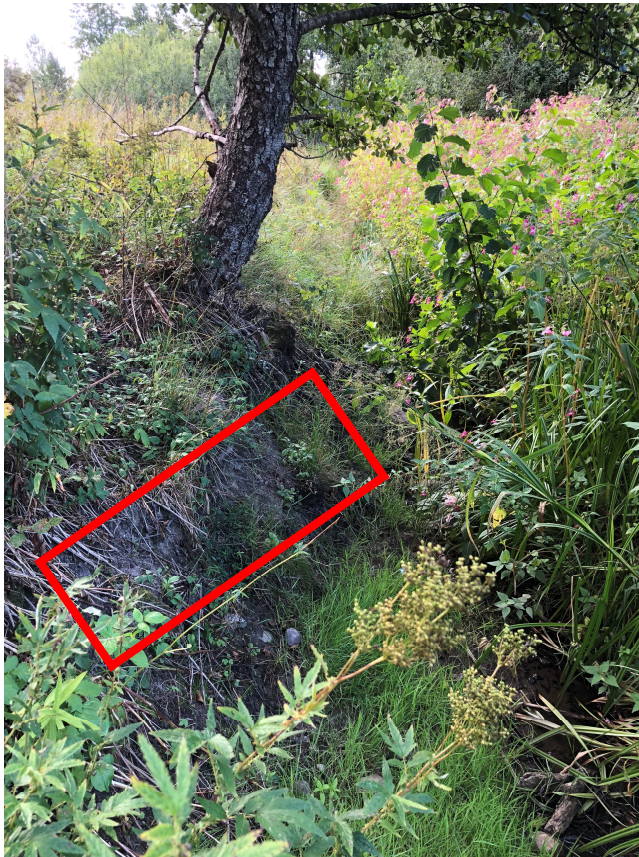
Figur 3. Foto av slänt mot väster, mindre parti av yterosion markerat med rött.
