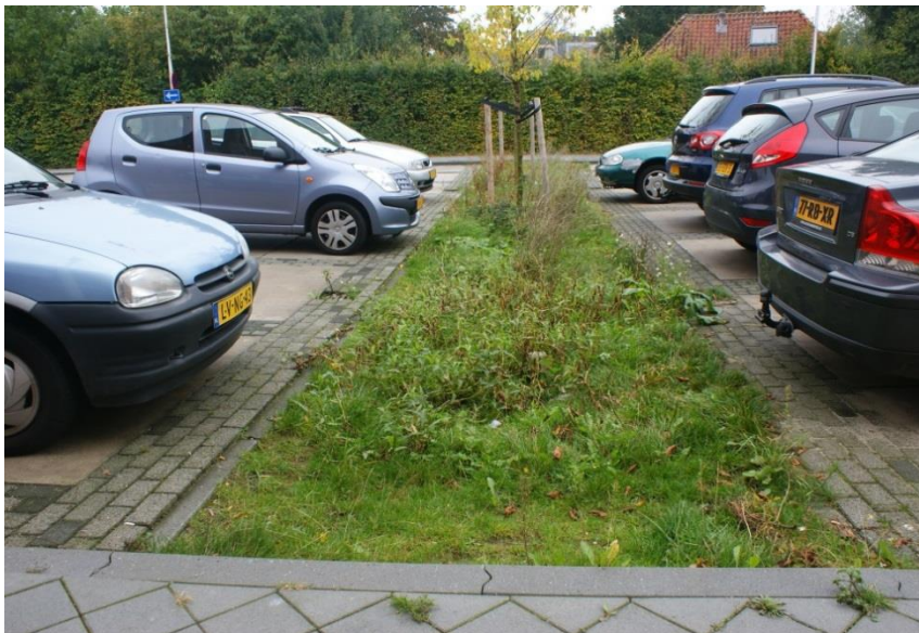
Figur 11. Exempel på utformning av växtbäddar (Foto: SVOA).
