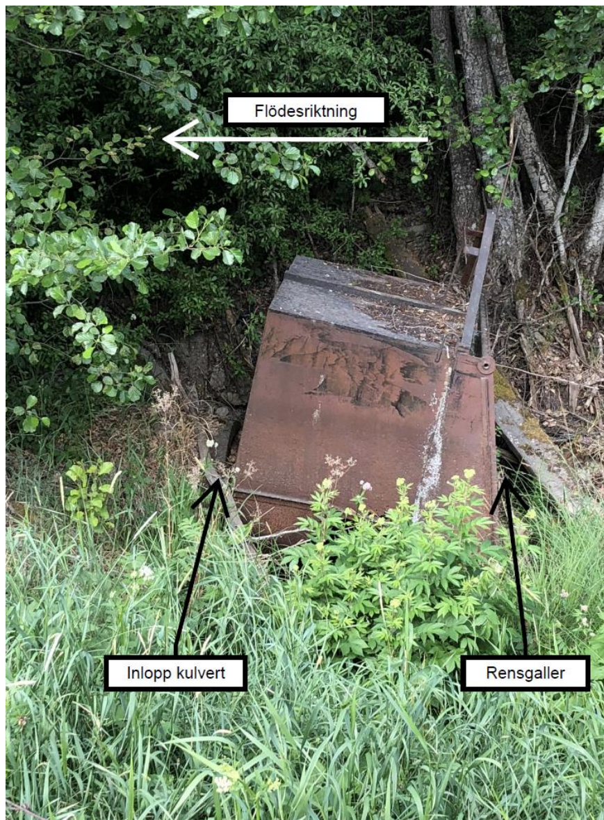
Figur 6. Inlopp till kulverten med tillhörande rensgaller. Foto taget vid sidan av Rävsjöbäcken, flödesriktning från höger till vänster i bild. Foto från platsbesök 2018-06-12.
