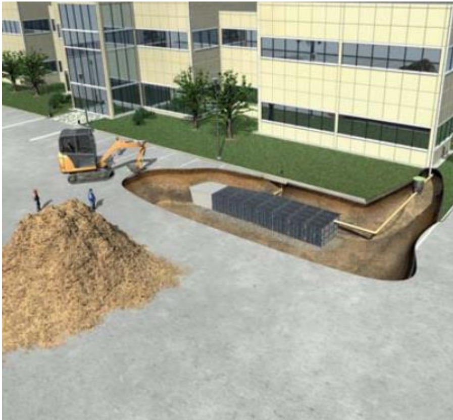
Figur 12. Exempel på installation av dagvattenkassetter. Foto: Uponor, 2013.
