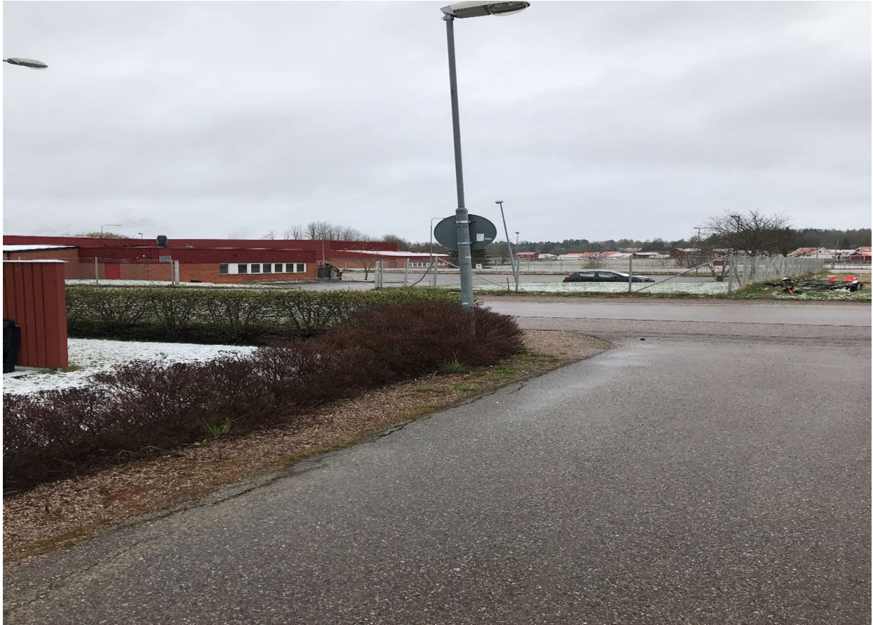
Figur 2. Bilden ovan illustrerar befintlig GC- väg mot Tegelvägen i sydlig riktning. Foto: Privat 20200428.
