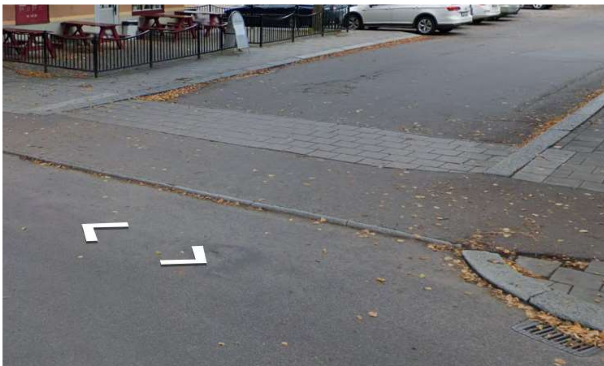
Figur 8. Bilden ovan visar fasade kanter av granitsten som en fartdämpande åtgärd på Södra Esplananden i Sala. Foto: Instant streetveiw.
