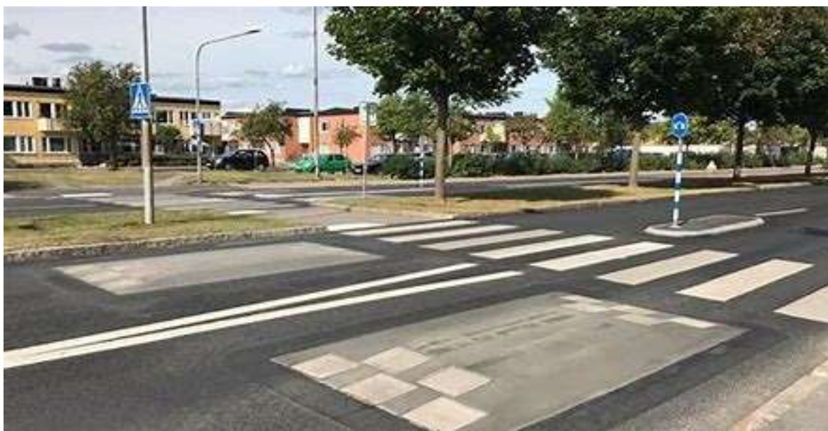
Figur 13. Bilden ovan visar vägkuddar som kan placeras på den nya lokalgatan innan cykelpassage/ cykelbana. Foto: Instant streetview.
