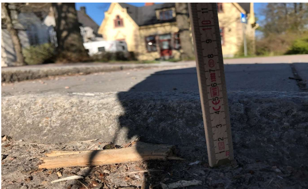
Figur 9. Bilden ovan visar höjden på kantstenen/ granitstenen. Den är cirka 5 centimeter hög. Foto: Privat.
