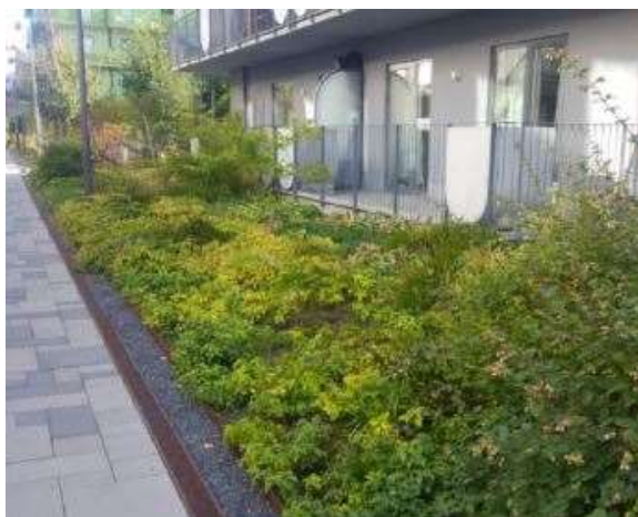
Figur 42: Exempel på nedsänkt växtbädd i marknivå (foto Sweco).
