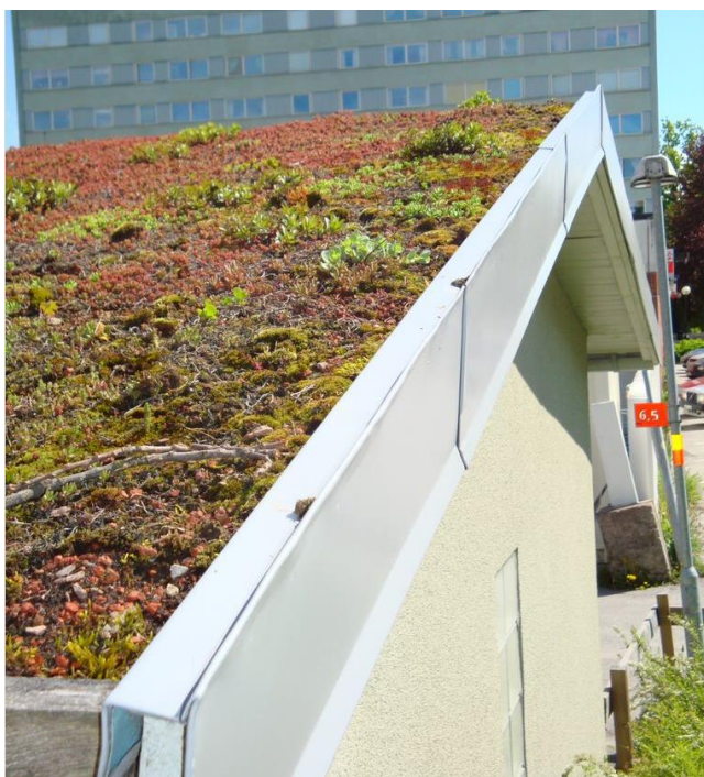
Figur 14. Exempel på ett extensivt tak på en byggnad. (Foto: Sweco)
