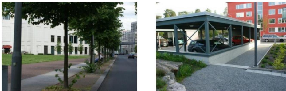
Figur 13. I vänstra bilden visas ett grusat respektive betongsatt gångstråk. Till höger visas exempel på markbeläggningar som ökar genomsläppligheten och som kan användas för gång- och cykelstråk.
