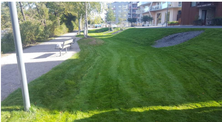
Figur 11. Exempel på torrdamm i bostadsområde. Bild: Sweco
