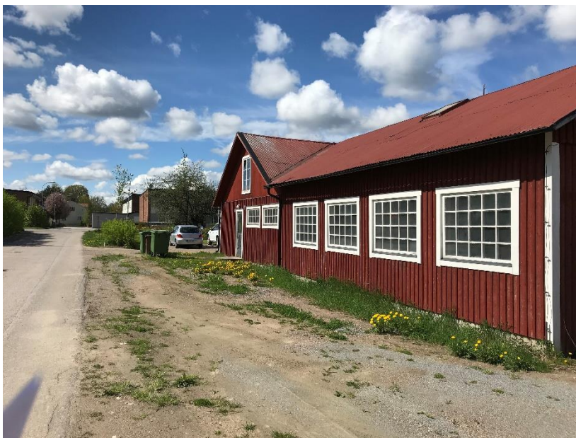
Befintligt uthus som kommer rivas, sett från Metallvägen.
