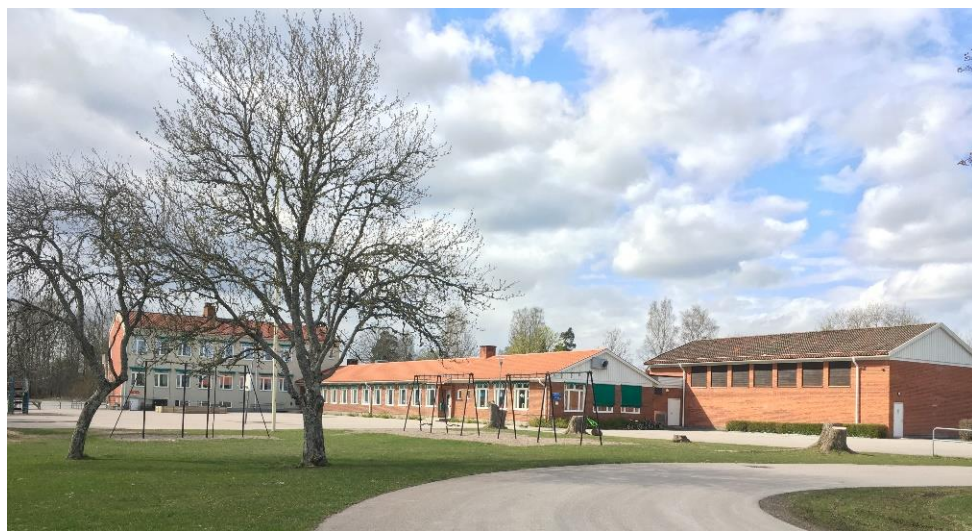
Befintlig skolbyggnad sett från sydost.
