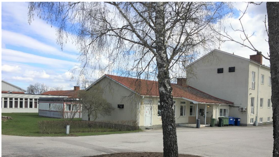
Befintlig skolbyggnad sett från norr.
